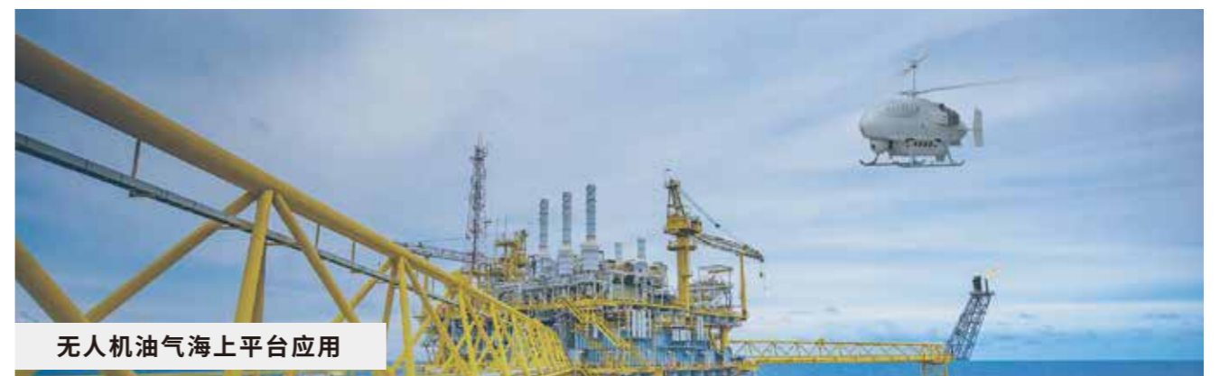
石油天然气管道空中巡检
